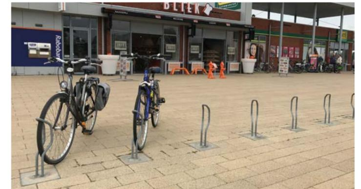
**Einzelparker zum Einbetonieren**
