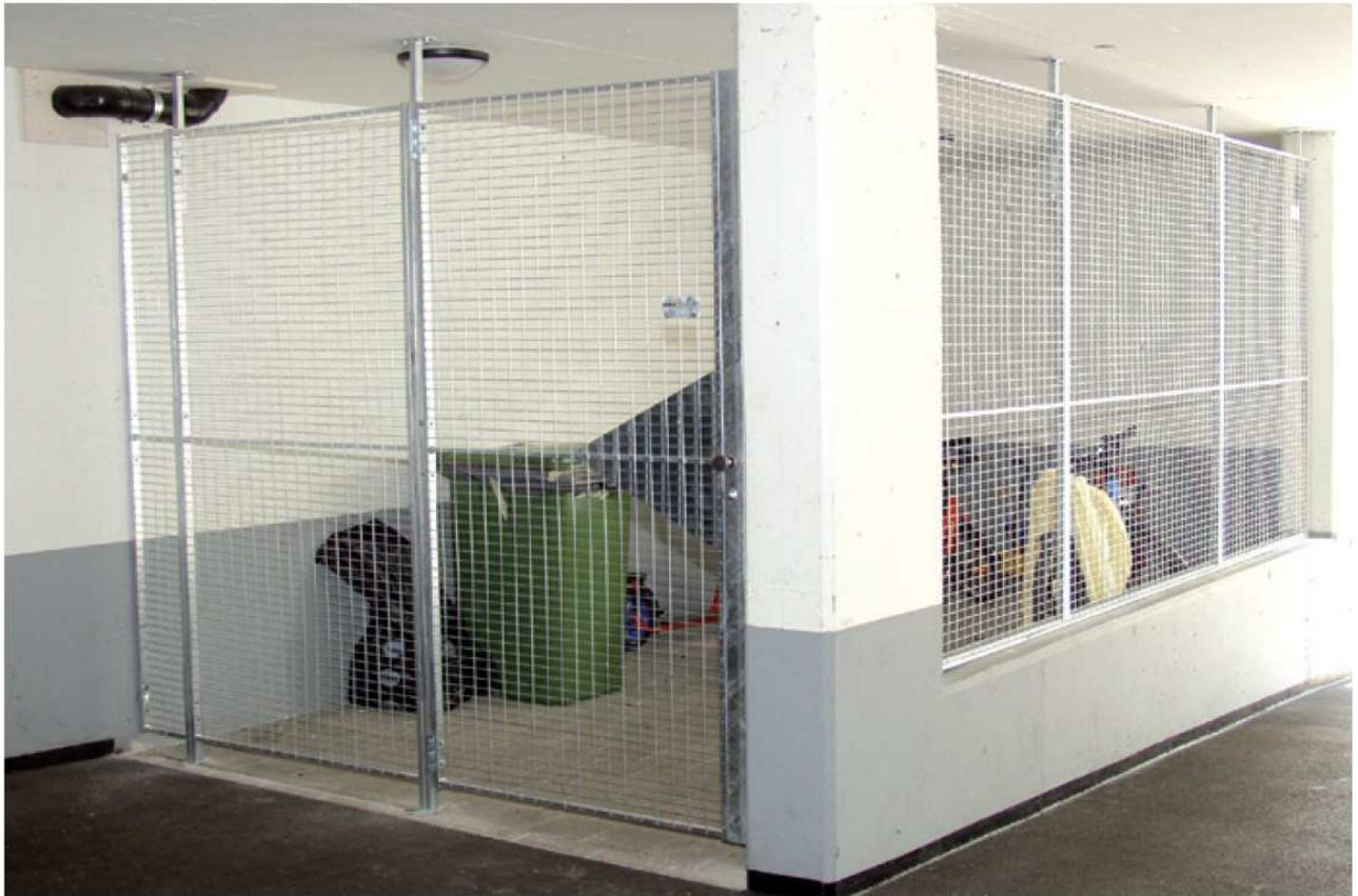
**Gittertrennwände für Haustechnik und Tiefgaragen**
